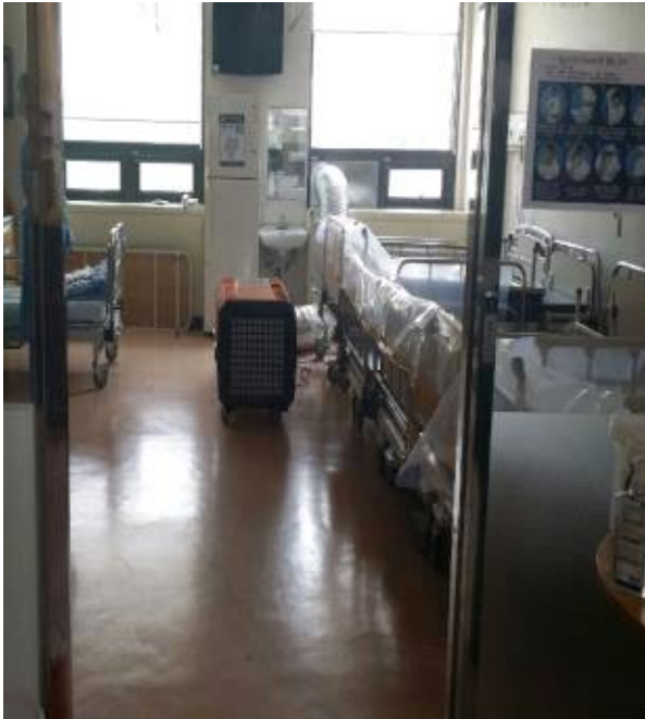
전실 및 음압기 설치
